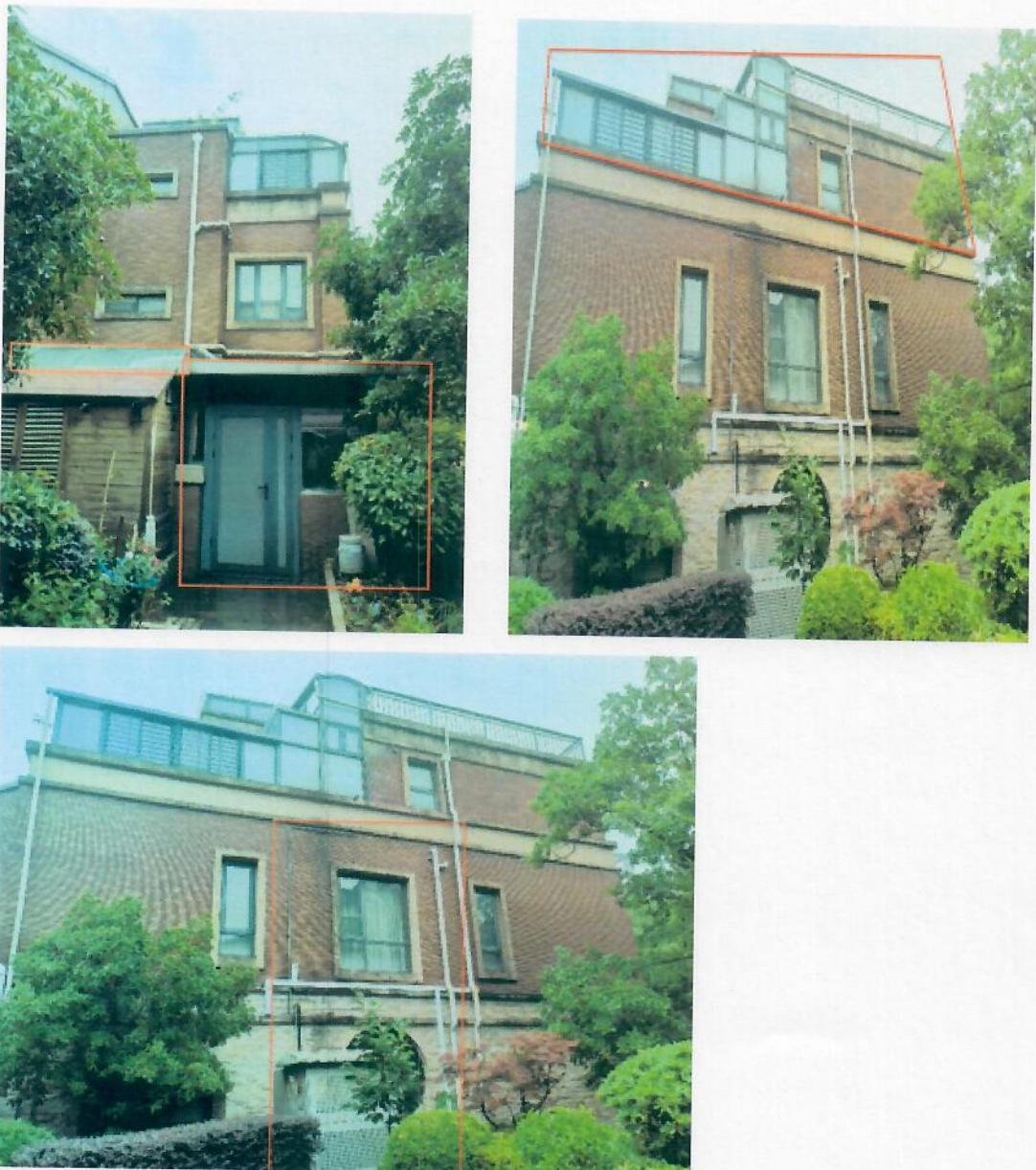
嘉定区洪德路 333 弄 110 号搭建情况：1. 一层北侧入户院子封闭搭建房屋，长约 6.3 米，宽约 1.5 米，面积约 9.45 平方米。2. 西侧内院部位封闭搭建房屋并向 上扩建两层，每层长约 3.6 米，宽约 3.6 米，面积约 12.96 平方米，砖混结构。3. 三层西北侧露台搭建房屋，长约 4.8 米，宽约 1.9 米，面积约 9.12 平方米，砖混 结构。4. 上方搭建阳光房，长约 2.4，宽约 1.9 米，面积约 4.56 平方米，玻璃框架 结构。5. 三层西南侧露台搭建房屋，长约 4.8 米，宽约 1.9 米，面积约 9.12 平方 米。
